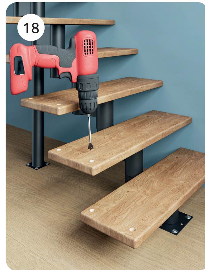
18. Делаем отверстия в ступенях для опор ограждения.
